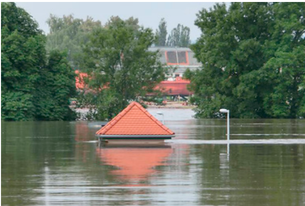
Flutung eines Gebäudes zur Probenahme an den Fassungsanlagen im Jahr 2013, Dresden
