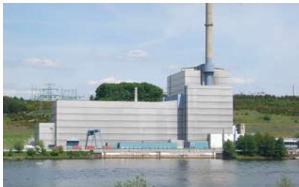
Kritische Infrastrukturen: Am 28. Juni 2007 geht der Reaktor in Krümmel nach einem Transformatorenbrand vom Netz
