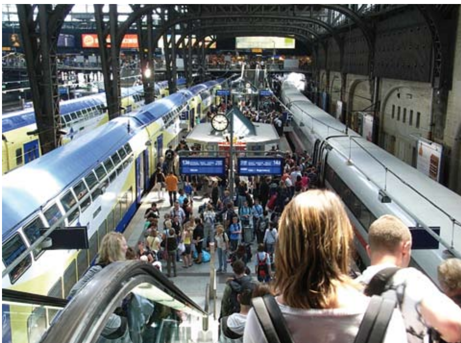
Kritische Infrastruktur: Große Bahnhöfe sind sensible Knotenpunkte im Verkehrsnetz, die nur schwer geschützt werden können
