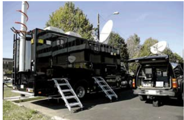
Intelligentes, mobiles IBM Notfall-Rechenzentrum, vorgestellt 2007 in Washington, DC, USA
