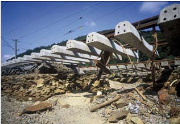
Zerstörungen von Bahninfrastrukturen – wie im Bild durch Hochwasser – können Versorgung und Bewegungsfreiheit der Menschen erheblich beeinträchtigen
