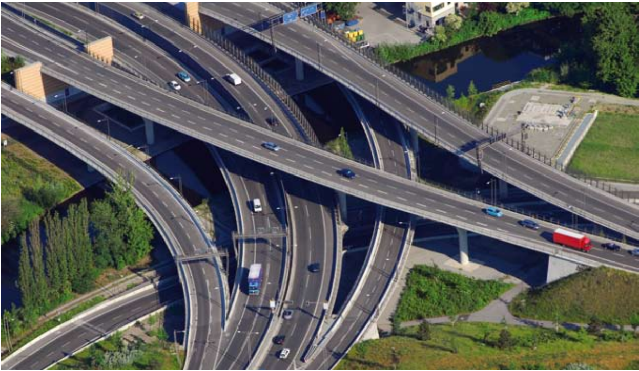
Der Schutz wichtiger Verkehrsinfrastrukturen ist für Deutschland lebenswichtig – im Bild: Autobahndreieck in Berlin-Neukölln
