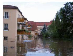
Hochwasser in der Stadt
