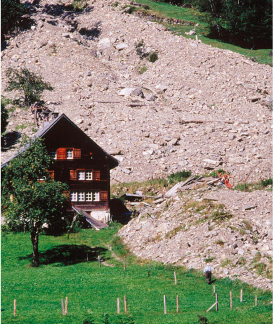
Der Anprall des Erdmaterials verursacht am Gebäude eine Stoßlast. Bereits leichte Hangrutsche können Risse im Mauerwerk verursachen und Fenster oder Glastüren beschädigen.
