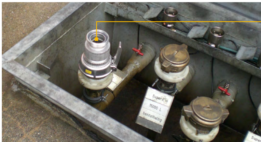
Abbildung 21 Übergangsstück TW/DN50 Schraubgewinde (Quelle: M. Tessin).
