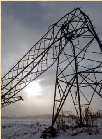
Abbildung 1: Umgeknickter Strommast im Münsterland (Quelle: THW).
